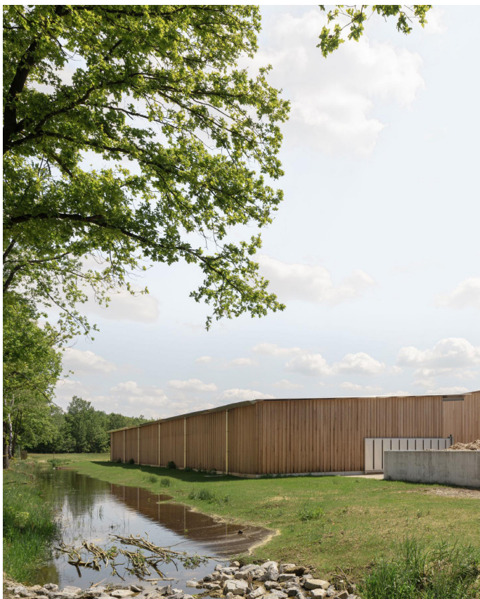
Přírodě blízké vsakovací nádrže Prinsenspark, Nizozemí, 2022
