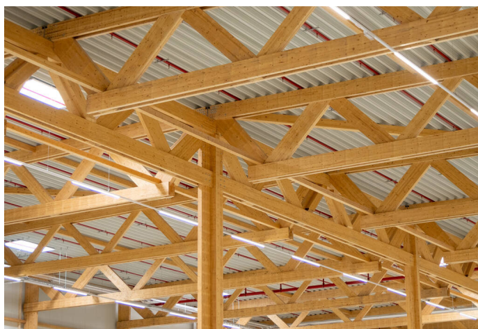
Greenrock Logistická hala s dřevěnou nosnou konstrukcí, Neuötting, Německo, 2023
