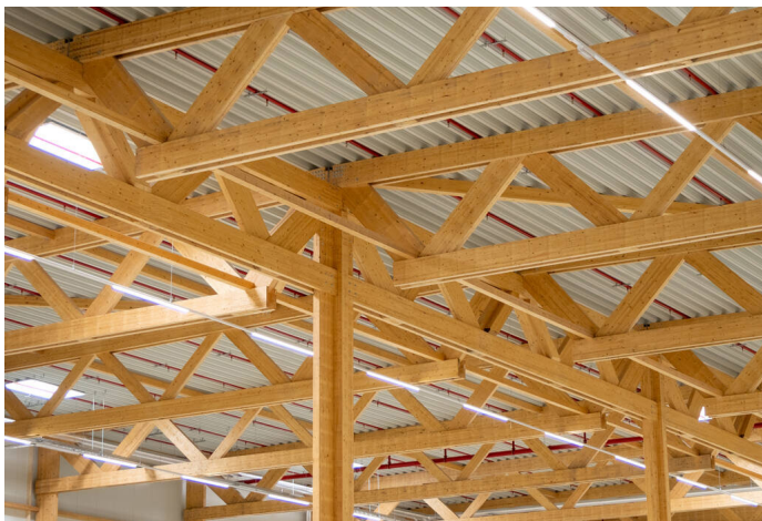
Greenrock Logistická hala s dřevěnou nosnou konstrukcí, Neuötting, Německo, 2023
