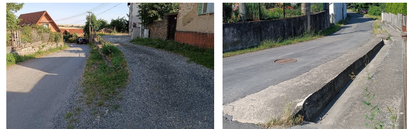
Obrázek 6 – Napojení domů č. p. 58 a 69 do ulice V Chaloupkách a nebezpečný příkop
