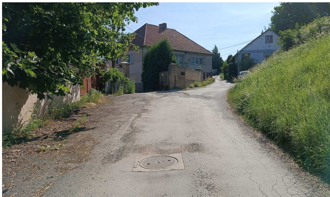
Obrázek 20 – Pohled směrem k vratům, u kterých může docházet k míjení vozidel
