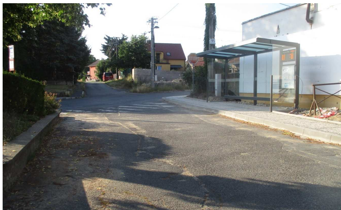
Obrázek 12 – Pohled ze Školské na nově vybudovaný přístřešek a chodník
