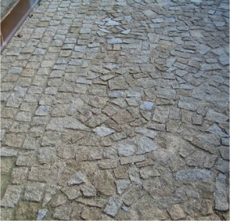
Detail A - komunikace - žulová dlažba odseky "divoká mozaika" odtokový žlab - žulové kostky SO 101
