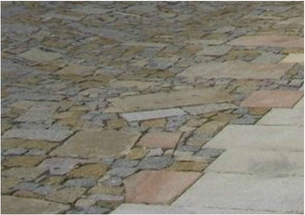
Detail B - žulová dlažba s dlažebními deskami "divoká mozaika" SO 102
